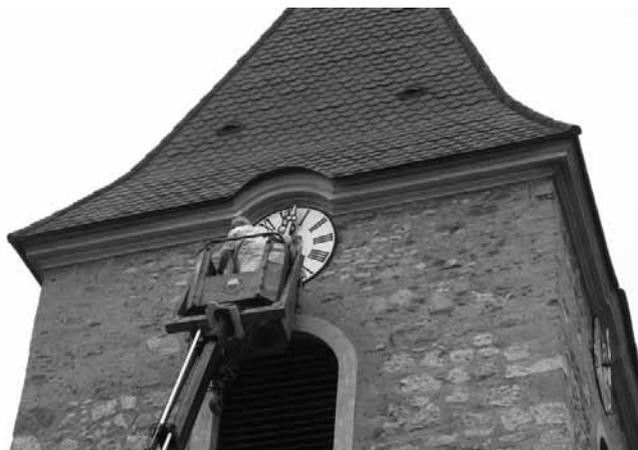
Seit einigen Wochen schien die Zeit in Immendorf stehen zu bleiben, da die Ziffernblätter der Turmuhr der Pfarrkirche abmontiert waren. Nach Renovierung der Antriebe der Zeiger und Neulackierung der 4 Ziffernblätter wurden diese am 10.10.2014 von der Firma Strupp GmbH aus Fuglau bei Horn wieder am Turm montiert.
